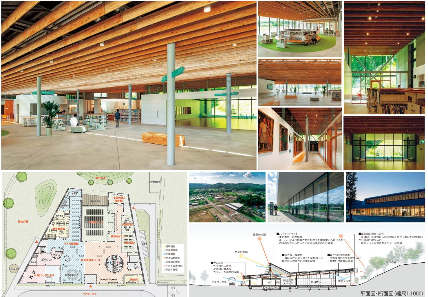
います。南北面のファサードは全面ガラス張りとし、南面バスロータリーからは市民をおおらかに迎え入れ、高さ5.5mとなる北面からは森の緑に反射した光や風を取り込みます。開放的な平面を実現するため、300φ以下の鉄骨柱を8.1mグリッドで配し、外周部のみにブレースを集約させてデザインと構造の融合を図りました。道産カラマツ合板を短冊状にカットした木ルーバーが天井全面を覆い空間の一体感を強調します。市民ワークショップで検討された様々な機能は、入れ子状の小架構やガラススクリーンにより空間を緩やかに仕切りながら注意深くレイアウトしました。刻々と変化する自然を身近に感じられ、多様な活動が大きな屋根の下に展開される、「小さなまち」のような建築が生まれました。市民が自由にくつろぎ交流する、新しい夕張の拠点となることを期待しています。
