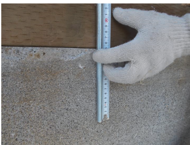
アンカー施工穿孔長 110 mm以上
