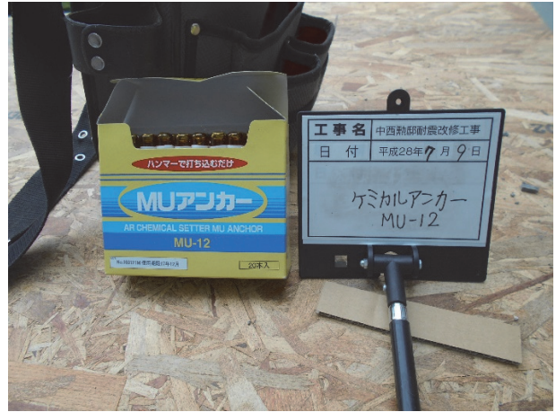
ケミカルアンカー M12用
