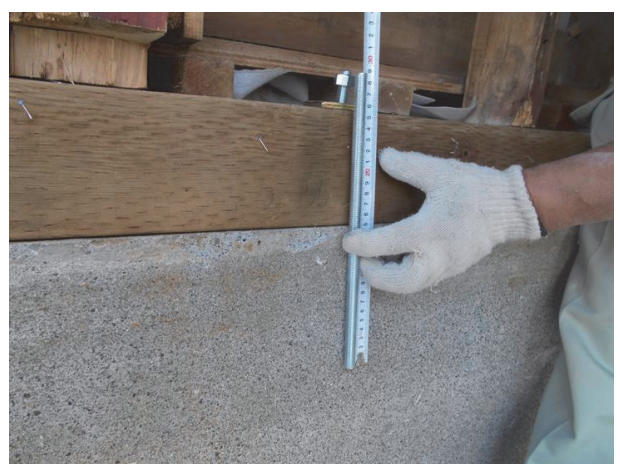
アンカー施工穿孔長 110 mm以上
